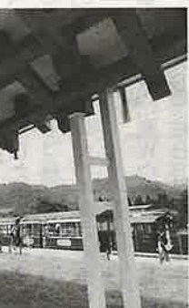
高森駅が木造で完成。駅舎が地上2階、交流施設が地上1階の木造で、整備面積約8550平方メートル、延べ床面積が駅舎約522平方メートル、交流施設261平方メートル。事業主体は高森町、協力は南阿蘇鉄道、くまもとアートポリス事務局(熊本県建築課内)。
